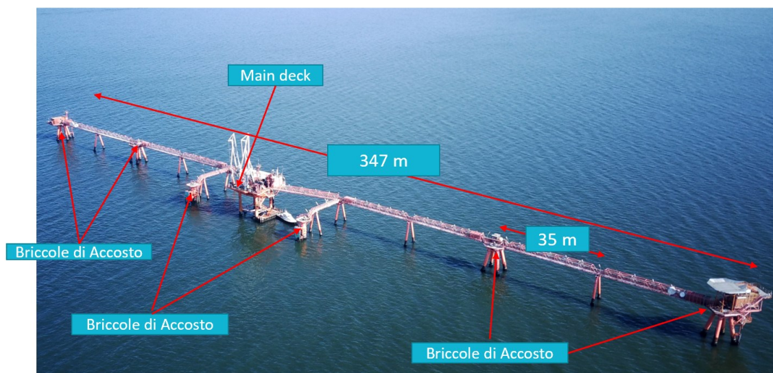
Figura 5.1: Struttura della Piattaforma Petra esistente
